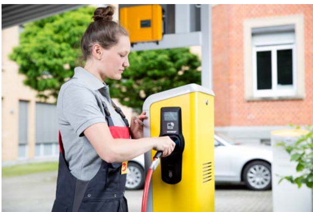
Abbildung 5: Ladesäule für Elektrofahrzeuge (Quelle: ZVEH)
