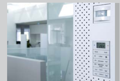
Präsenzmelder sorgen dafür, dass das Licht nur angeht, wenn wirklich jemand im Raum ist – und sich ausschaltet, wenn die Person den Raum verlässt.
